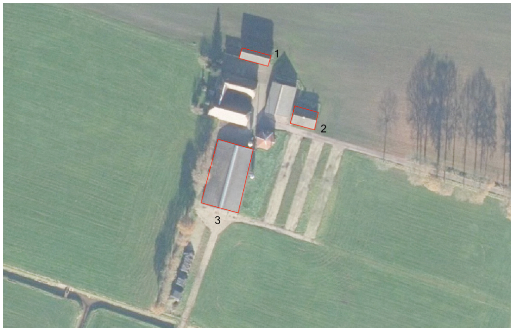
Figuur 2. Luchtfoto plangebied uit 2014 met in rood de te slopen bedrijfsgebouwen. (bron: provincie Overijssel)
