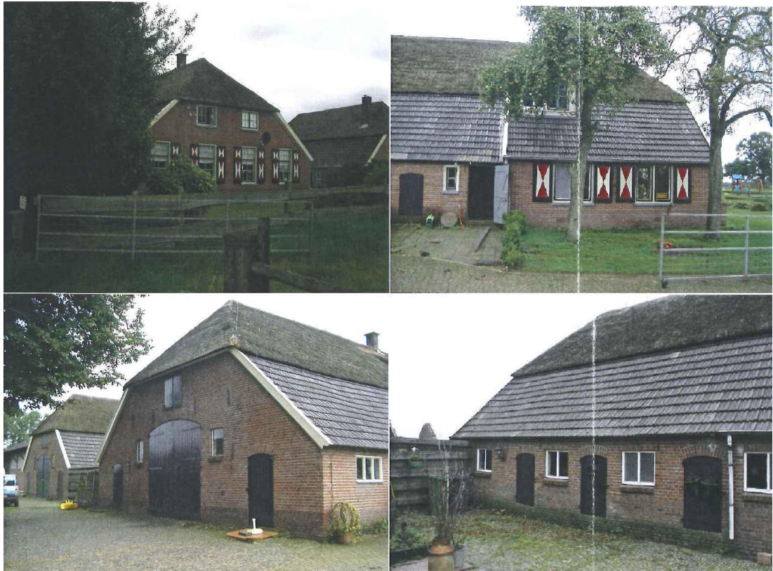
Foto's bestaande situatie: vanaf linksboven met de klok mee: 1: voorgevel winter- en zomerboerderij; 2: linkerzijgevel winterboerderij; 3 achtergevel zomer- en winterboerderij; 4. linker zijgevel zomerboerderij
