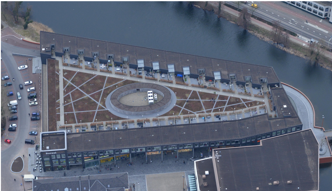
Bovenaanzicht van de woningen in het plangebied
