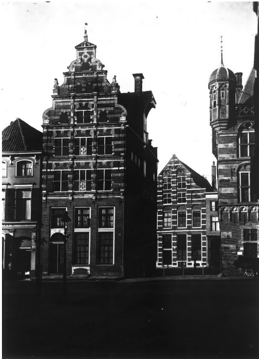
Afb. 15: De gevel van Brink 69 voor de 'restauratie' in 1963 (foto HCO, 1929).
