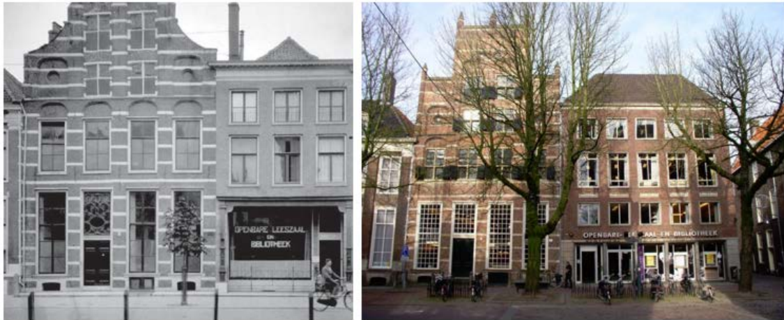
Figuur 2.5 Bibliotheek voor de verbouwing in 19642 en de huidige situatie
