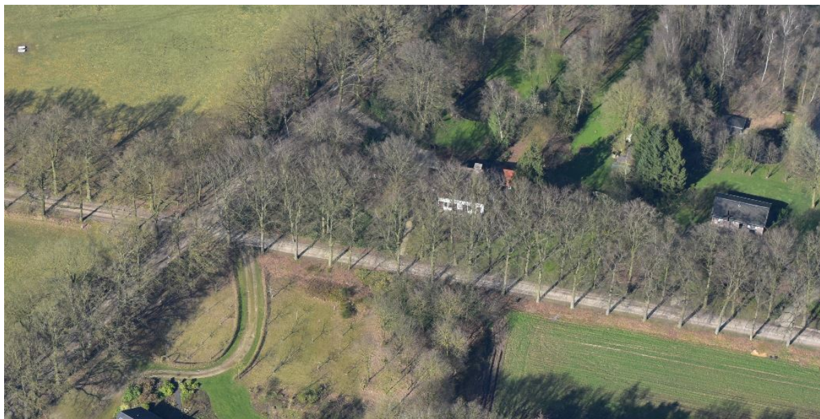
Figuur 6: Butersdijk (wegvak 1 -westelijke deel)
