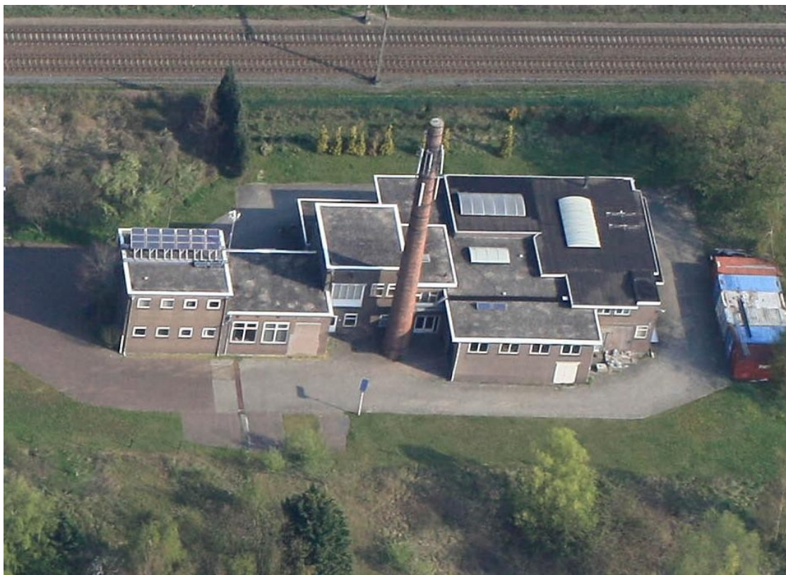
Beeldbepalende schoorsteen Stationsweg 18
