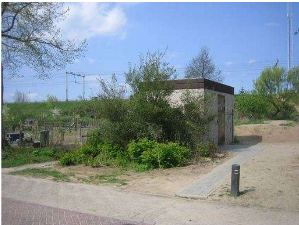
Nutsgebouw in plangebied
