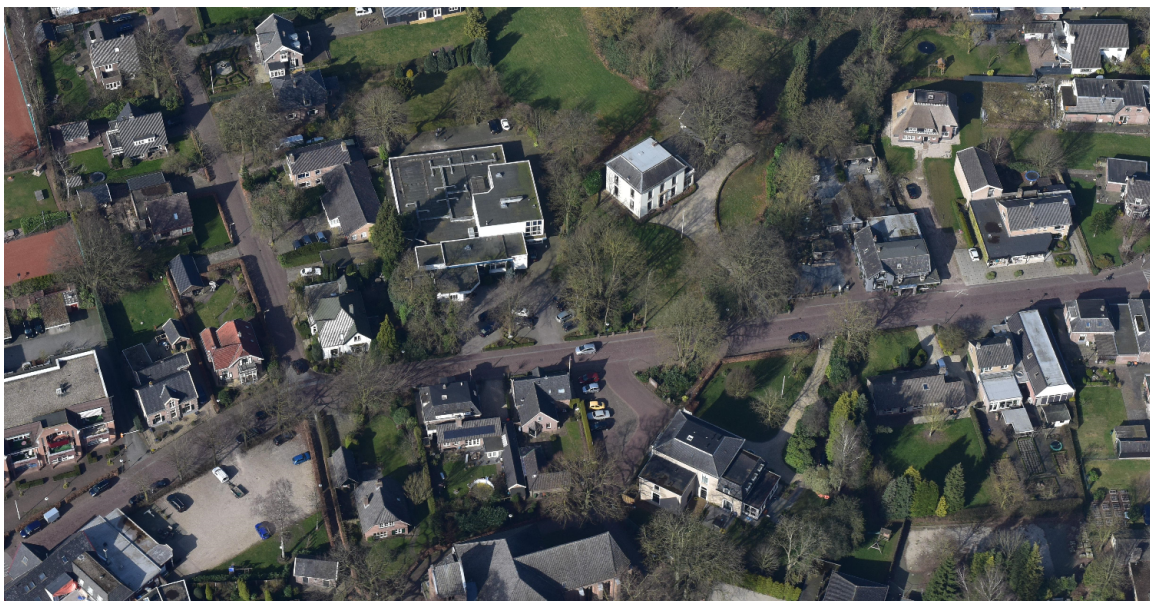
Luchtfoto van de huidige bebouwing van de voormalige Rabobank
