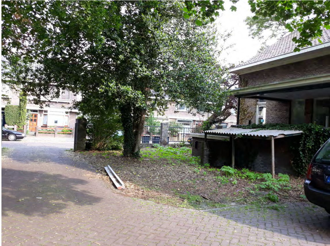
Open afdak met asbestgolflaat en onverhard, westelijk van boring 509
