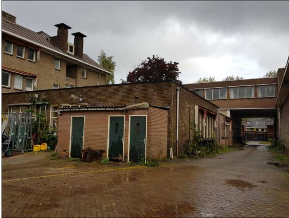
Figuur 5. Boilergebouw oostzijde van het complex
