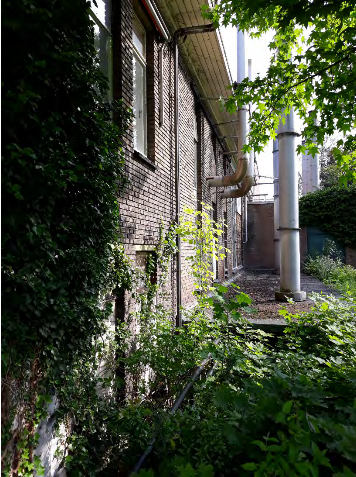
Vml ketelhuis (1) met ontluchtingen van vml tank nog aan de muur
