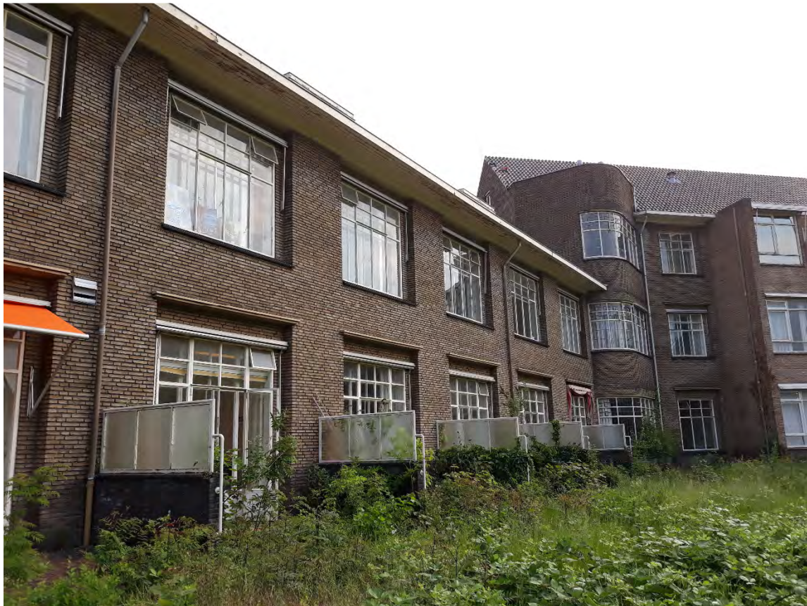
Zicht op bestaand gebouw, nabij boring 306
