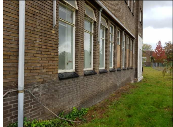
Figuur 6. Gevel zuidvleugel van het complex
