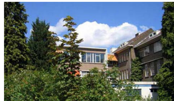
Huidige laagbouw tussen de beddenvleugels wordt gesloopt
