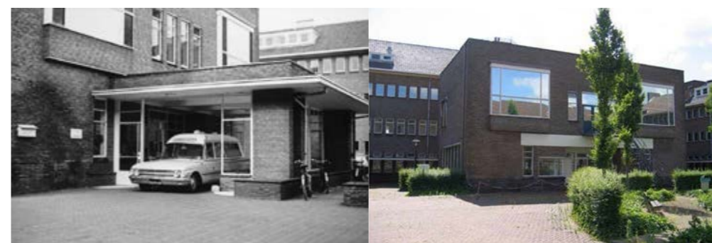
Te slopen voormalig opnamegebouw/operatiekamer op de binnenhof
