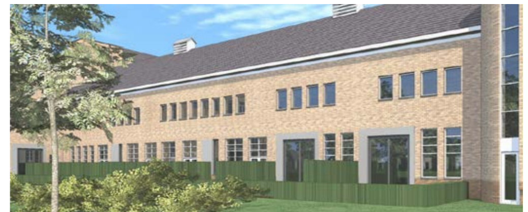
Nieuwe openingen vormen toegang tot de buitenruimte bij de woningen
