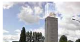
HOGESILO MET ELEVATORGEBOUW
