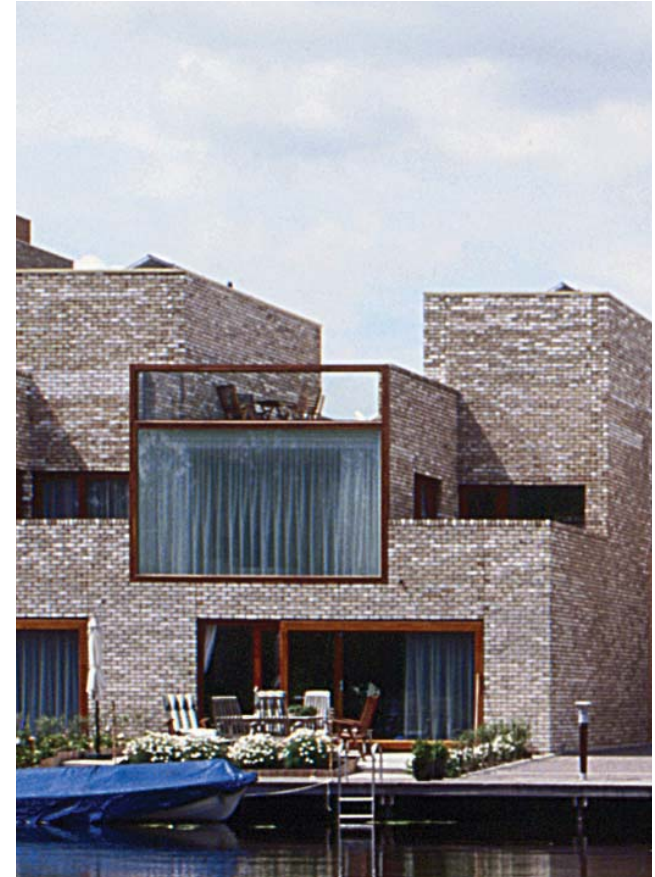
combinatie van metselwerk, hout en glas
