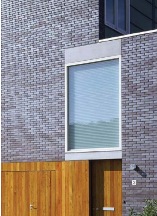
combinatie van metselwerk, hout en glas
