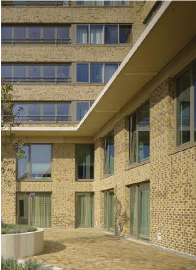
combinatie van metselwerk, hout en glas
