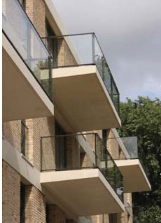
combinatie van metselwerk, beton en glas
