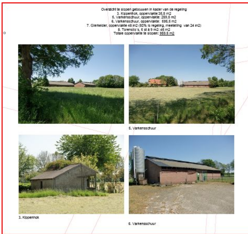
Te slopen bebouwing
