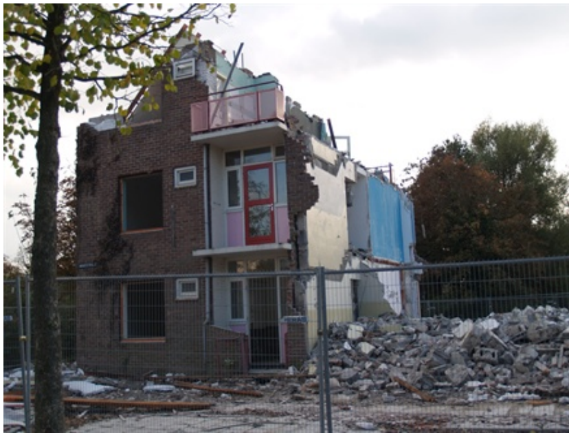
gesloopte bebouwing Maasstraat
