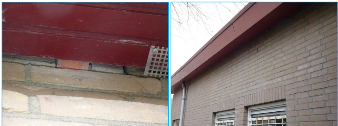
Foto's: Openingen/ stootvoegen die toegang kunnen bieden naar vaste verblijfplaatsen van vleermuizen.
