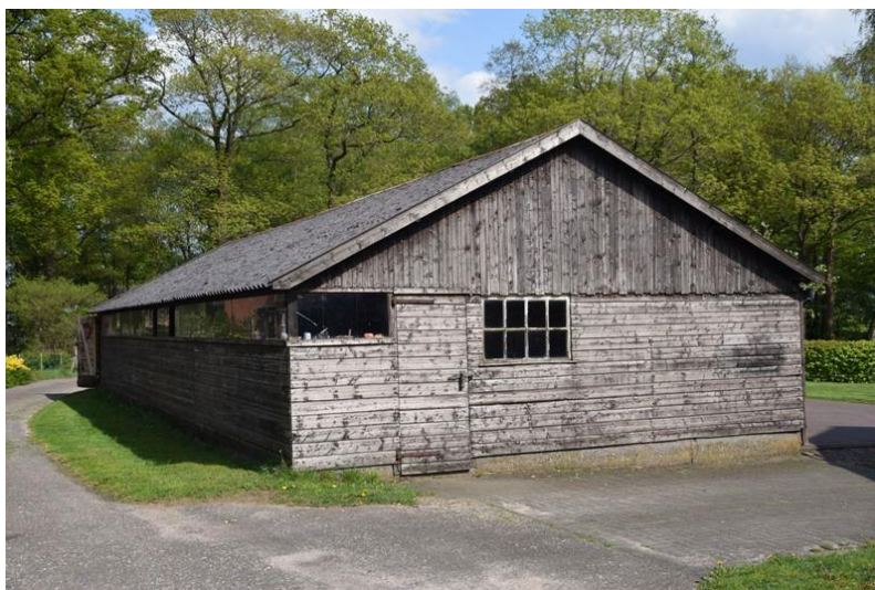
Figuur 6: Karakteristieke schuur
