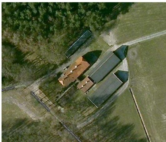
Figuur 2. Luchtfoto huidige situatie. De te behouden gebouwen A en C bezitten een oranje dak.
