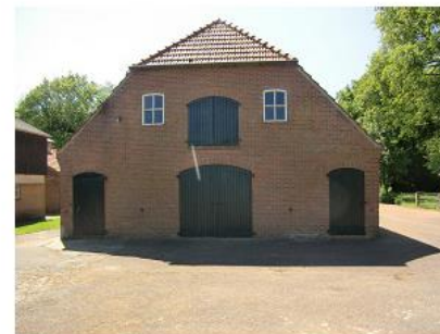
Achtergevel van de boerderij
