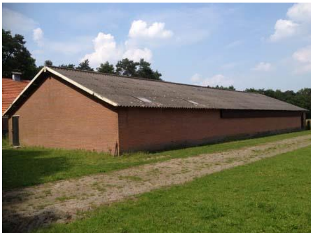
Foto 5. Stal E vanaf het zuiden gezien.
