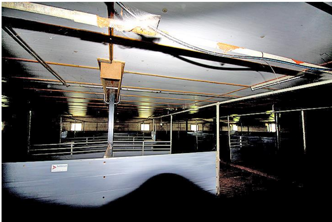
Plangebied stallen binnenzijde
