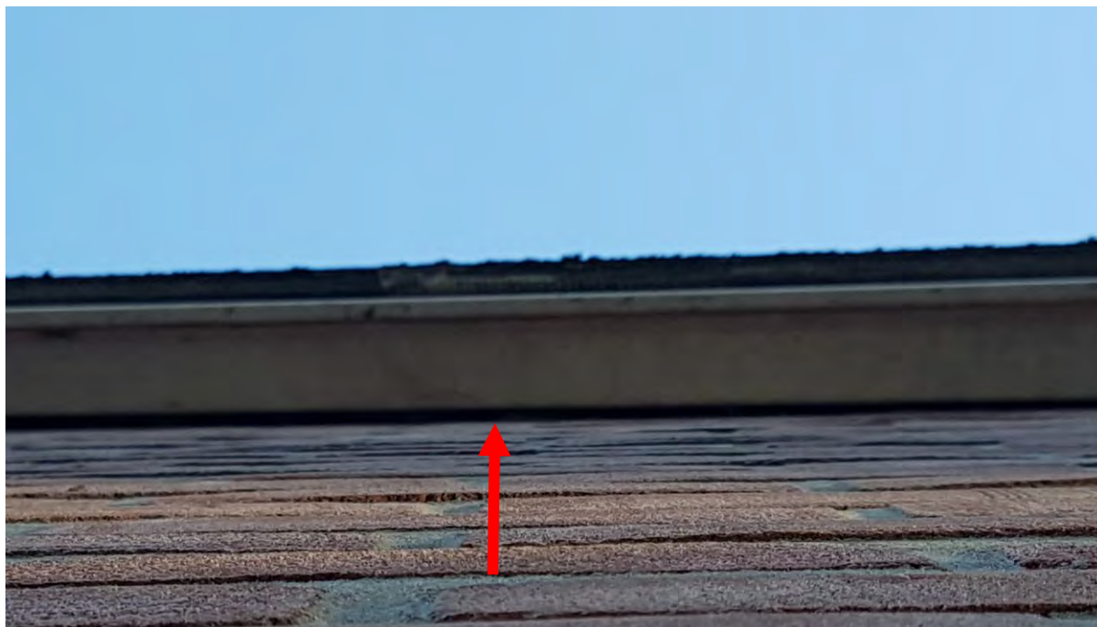
Figuur 5.9. Ruimte tussen muur en windveer in te slopen garagebedrijf (bron: Eco Reest).
