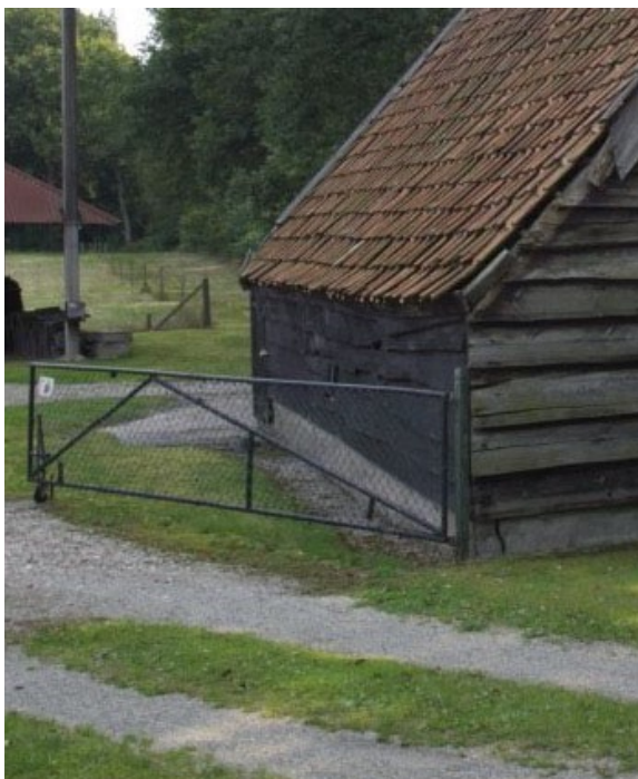
Afbeelding 67. Referentie halfverharding en houten gevels
