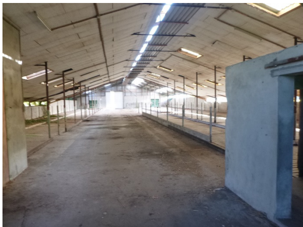
Binnenzijde voormalige ligboxenstal
