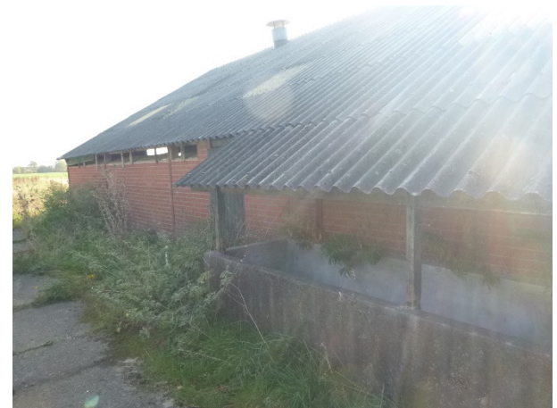
Druppelzone A en lekbak voormalige diesel-tanks met overkapping
