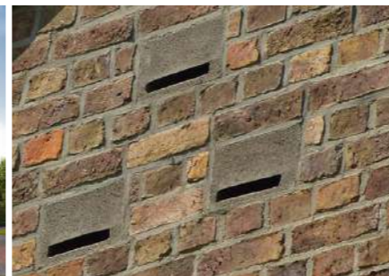
inbouw neststenen in kleur baksteen en onderdeel van architectuur
