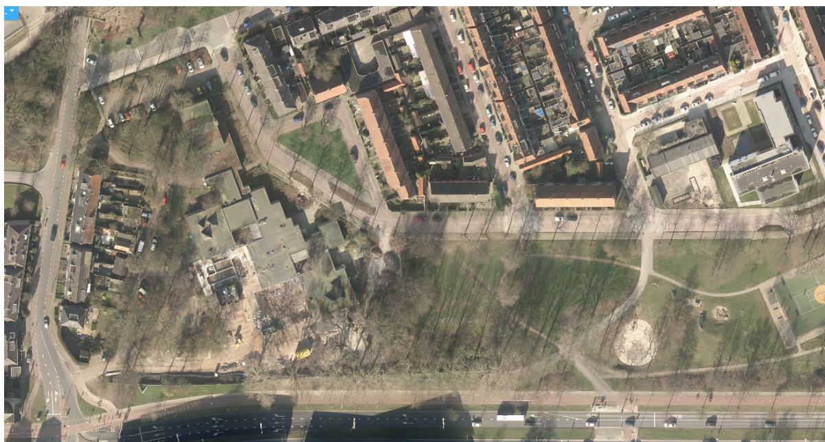
Luchtfoto begin 2016; de sloop van de school is begonnen
