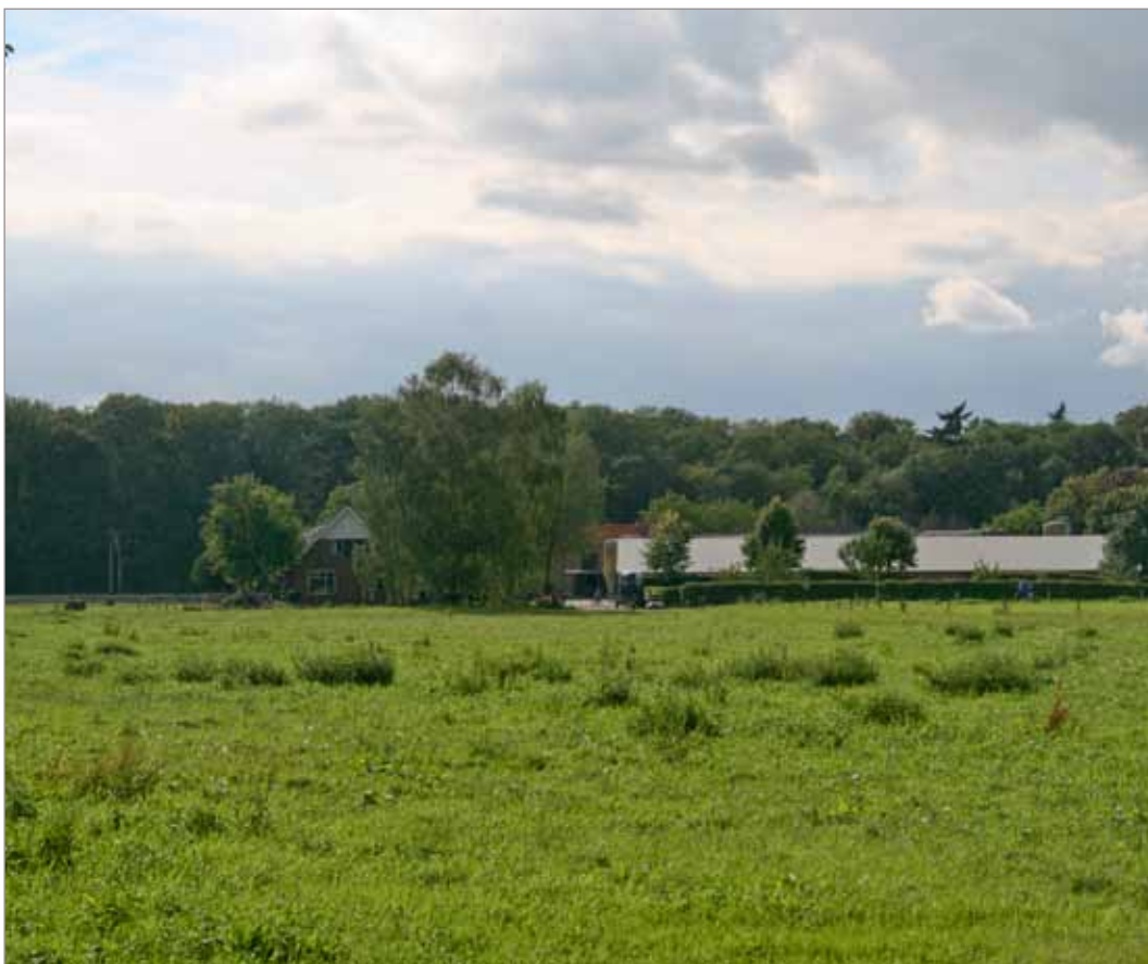
Afbeelding 7. Te slopen bebouwing
