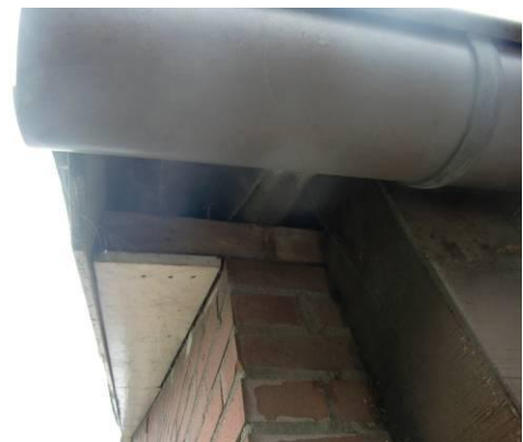
Afbeelding 5.2. Dakbetimmering gebouw A en ruimte tussen dak, plafond en spouwmuur.
