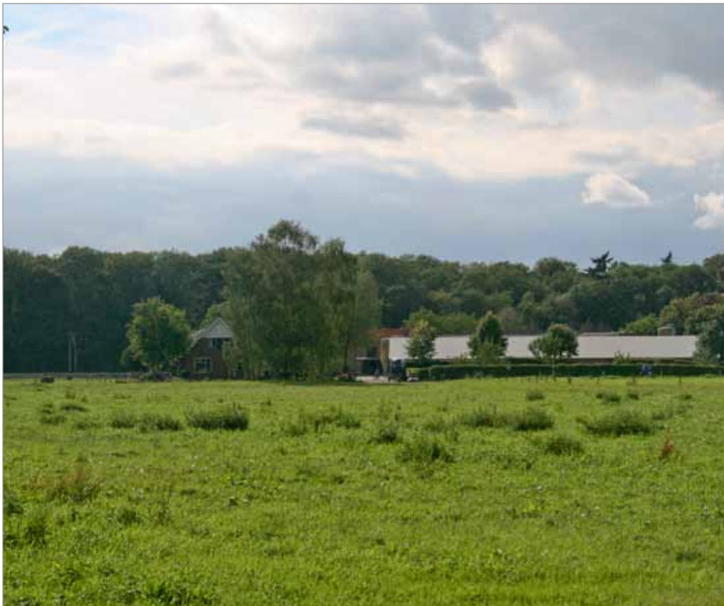
Afbeelding 7. Te slopen bebouwing
