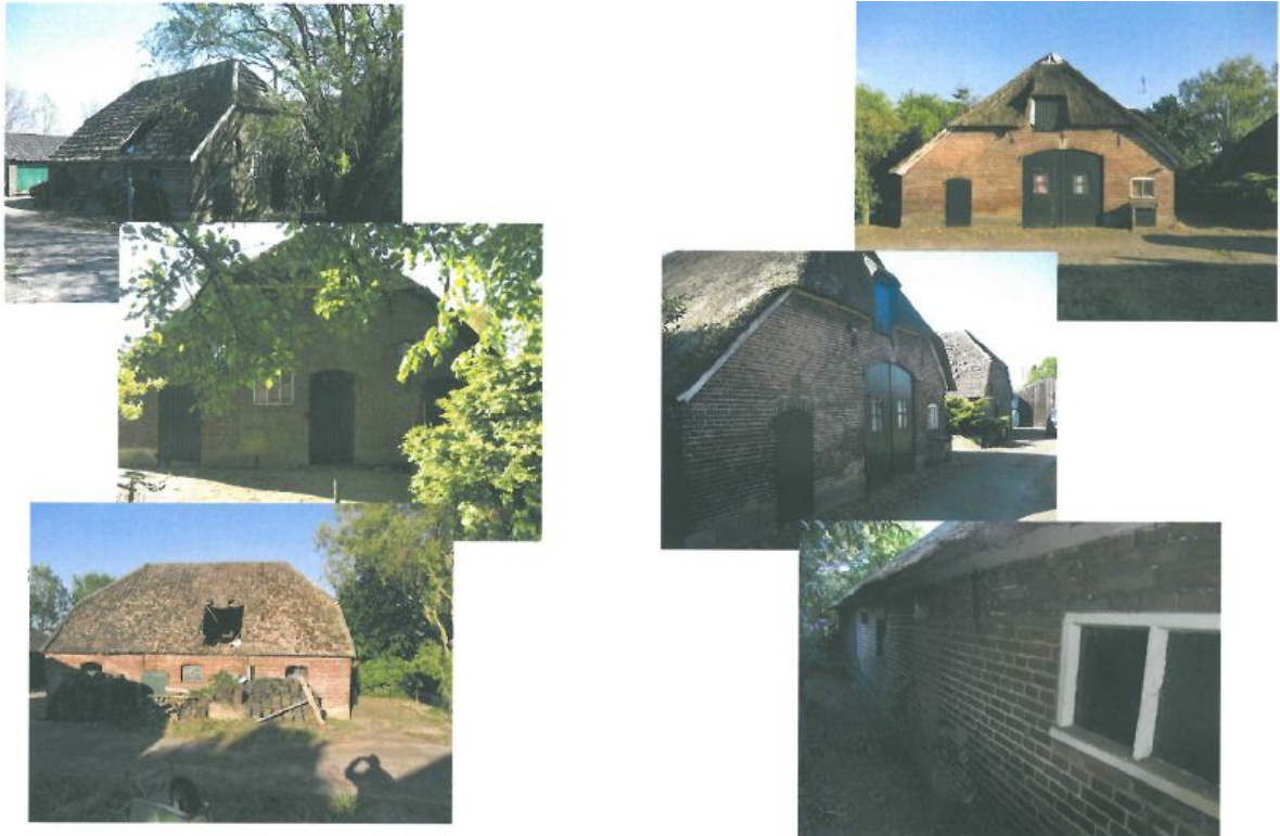
Foto's bestaande opstallen op het perceel "Schooldijk 1"
