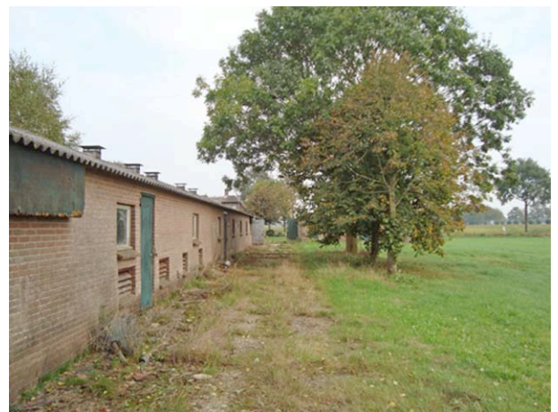
Foto 6. Achterzijde erf naar de weg gezien met links gebouw 5 .
