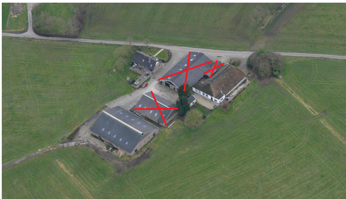
Figuur 8: Luchtfoto: met de rode kruizen is aangegeven welke landschapsontsierende schuren op het erf Spandjaardsdijk 52 worden gesloopt.
