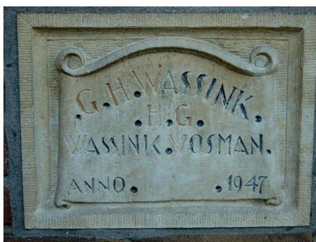
Ingemetselde steen met opschrift naam opdrachtgever en architect
