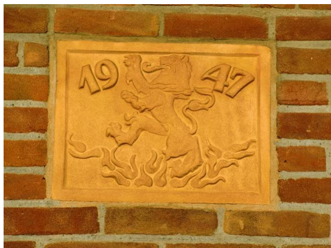
Ingemetselde steen in gevel van boerderij, herstel oorlogsschade
