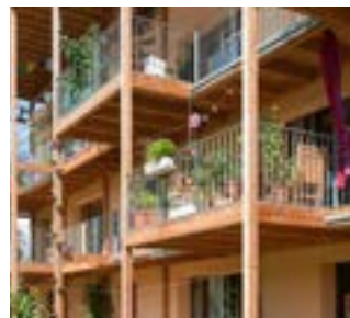
galerij als verblijfsruimte
