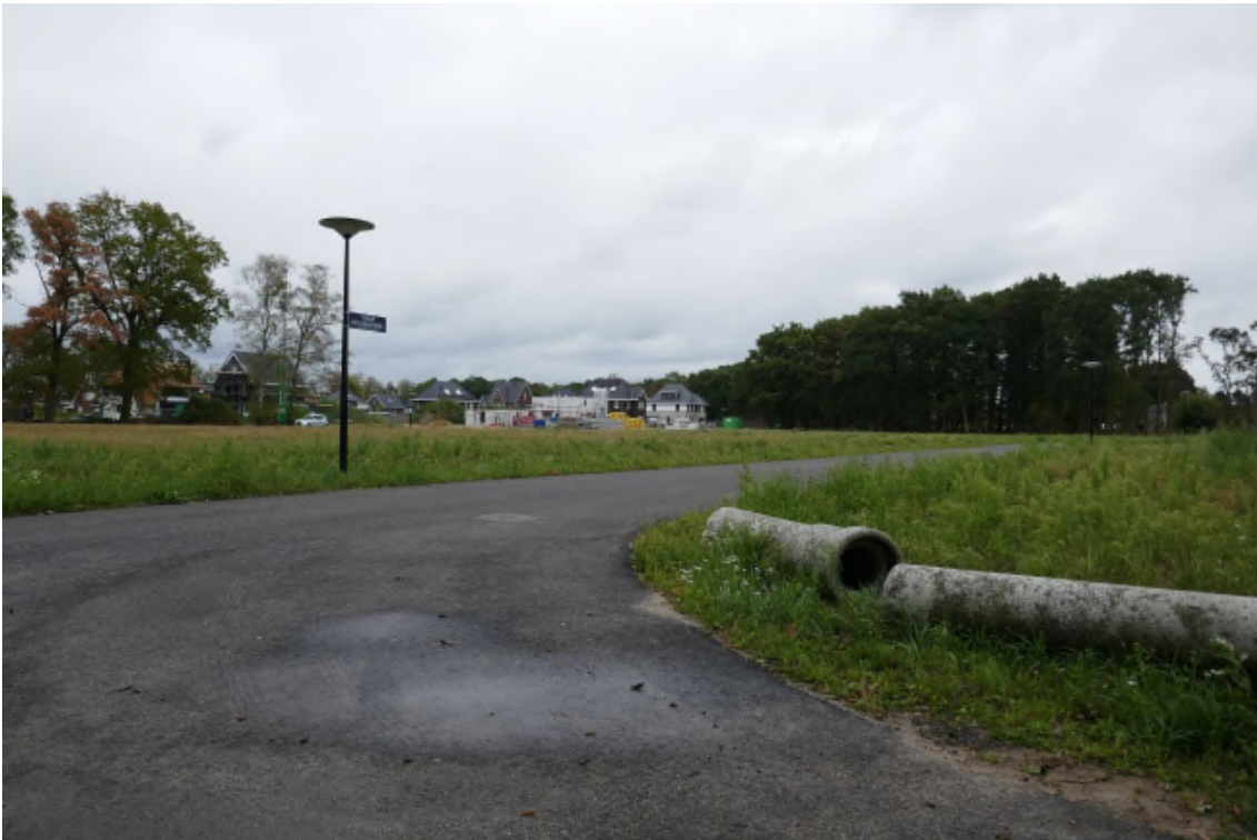
Tjeenk Willinkstraat (blok 7) met daarachter de bebouwing aan Colenbranderstraat van blok 6.
