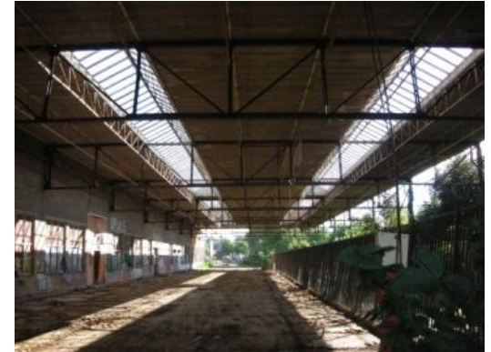
Oude fabriekskap T&D langs het spoortalud, is najaar 2009 gesloopt.
