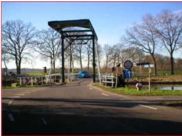
De Zandbelterbrug met haar smalle wegprofiel en aslastbeperking van 4,8 ton
